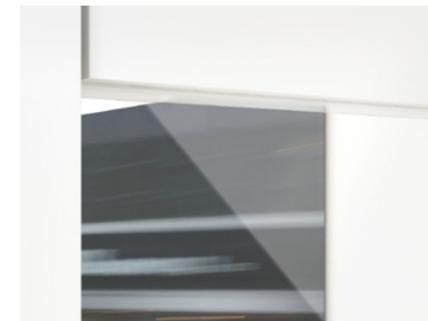
Übergänge zwischen Glas und Holz durch Dichtlippe abgeschlossen
